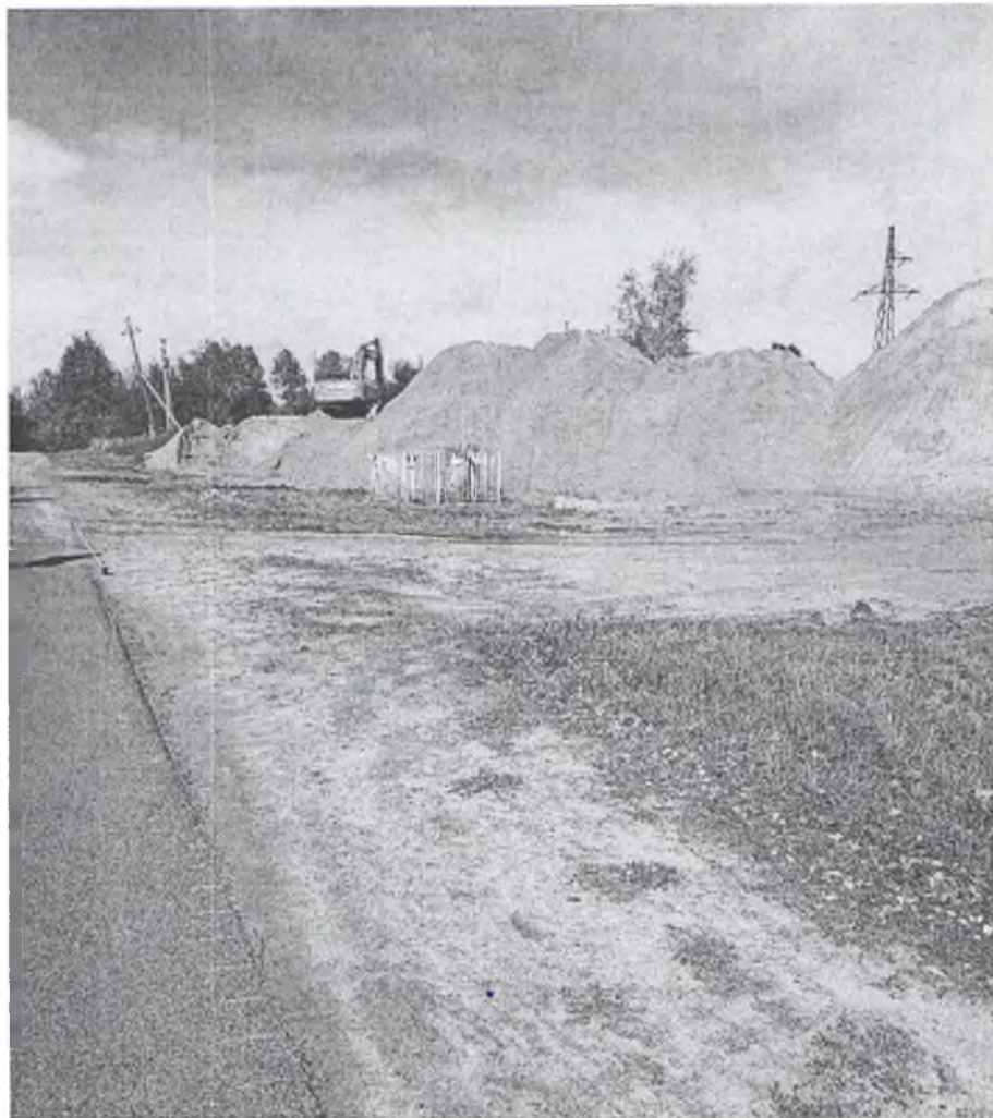
Фото 4. Планируемое место съезда транспорта ЖКХ, обслуживающего дороги. (Вид со стороны дороги)
